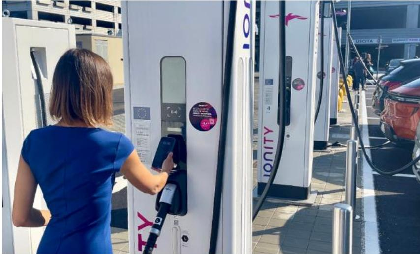
Le colonnine di ricarica nell'hub sono in tutto 19, perché si aggiungono anche le **12 di Atlante (di cui 8 da 150 kW e 4 da 300 kW)**, e le **altre 8 del Tesla Supercharger**. L'azienda di Elon Musk è presente nell'area anche con il Tesla Store Udine. Tutte le colonnine sono alimentate con energia certificata 100% rinnovabile.
